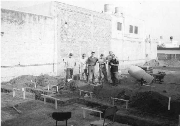
Cavando los cimientos para el nuevo salón de la iglesia El Renuevo.
