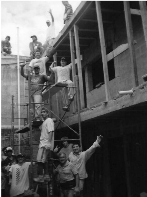
Construyendo las aulas y baños para la Escuela Bíblica.
